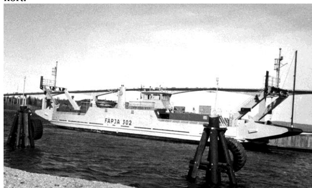
FÄRJA 302 under reparationen av Alnöbron 1987.
